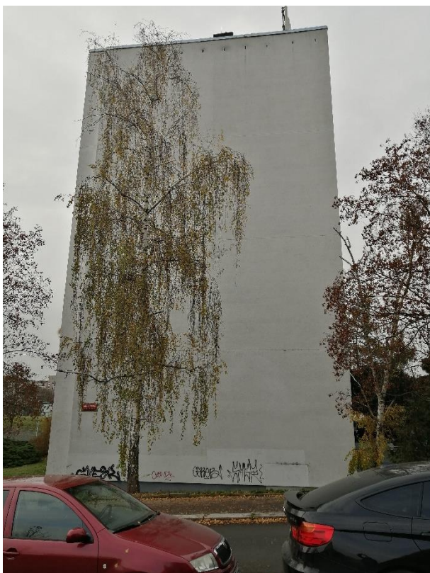
Štítová fasáda (východní + západní):
